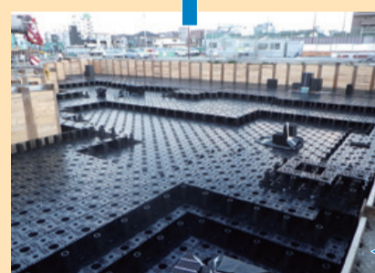
地面を掘って材料を積み上げる
