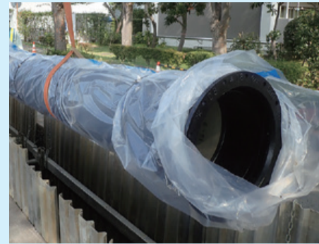
▲水道管の更新工事
