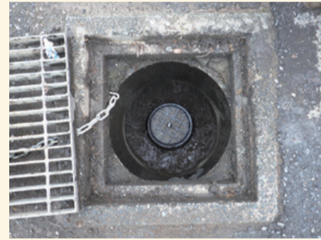
▲降った雨を集め、地下に浸透させる改良工事後の雨水ます
