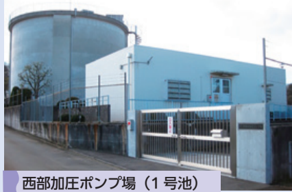
西部加圧ポンプ場(1号池)
